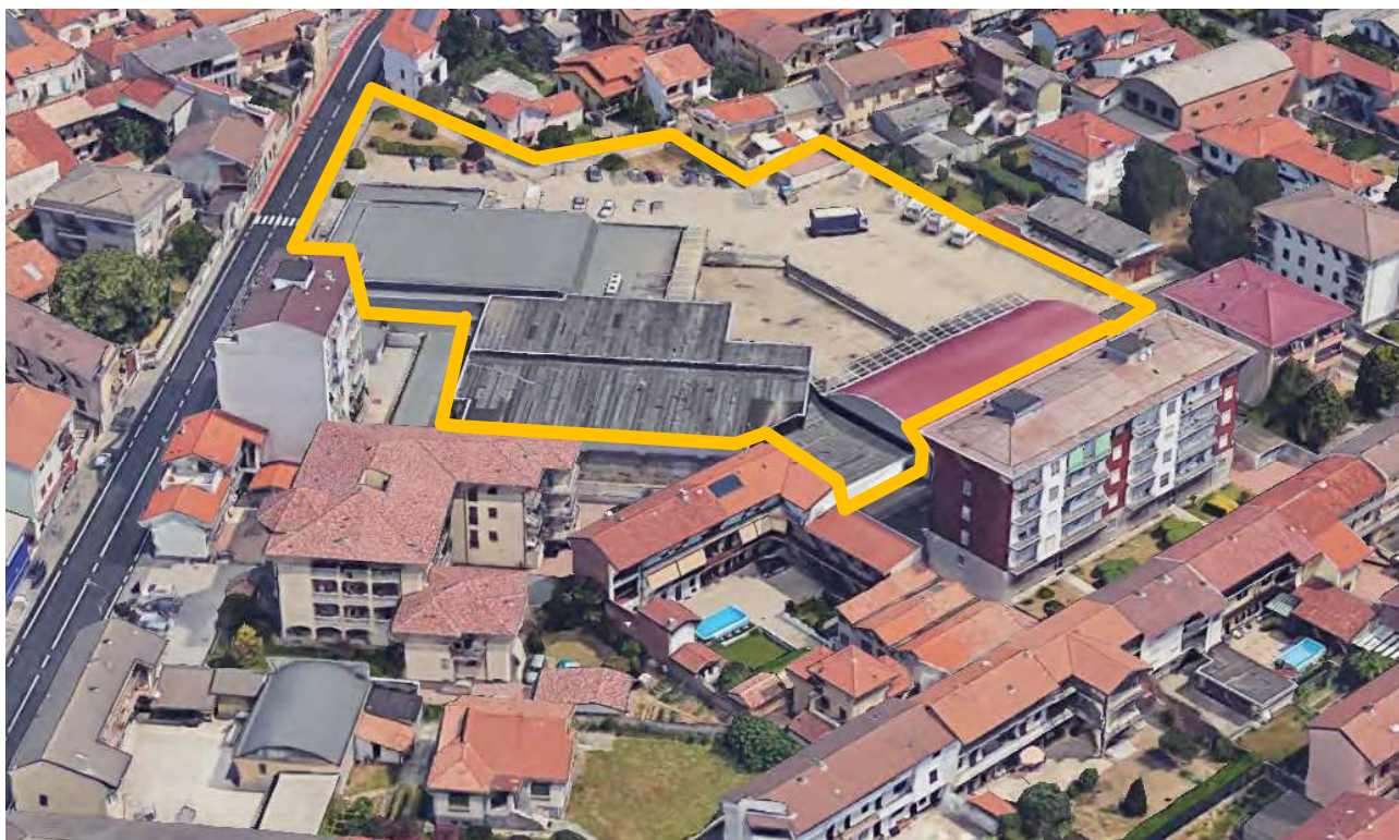
i) Ripresa fotografica dell'Ex-magazzini Coop da sud-ovest
