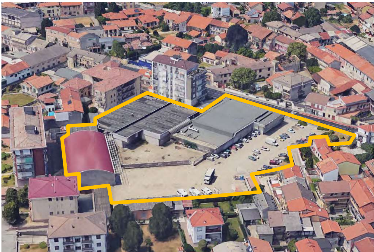
g) Ripresa fotografica dell'Ex-magazzini Coop da est
