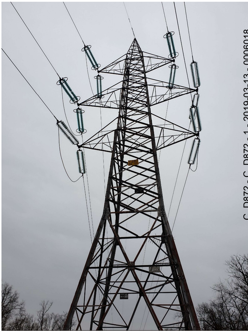
Traliccio linea T.287 – 220 kV
