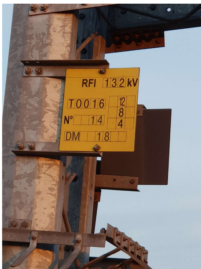
Traliccio doppia terna T.M16-T.T42 – 132 kV
