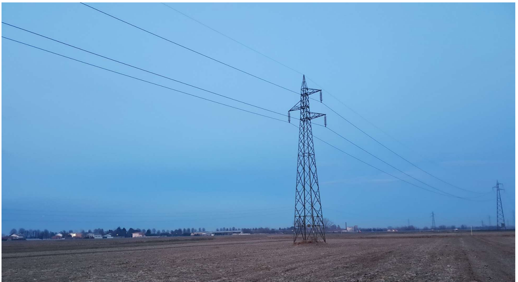
Traliccio linea T.467 – 132 kV
