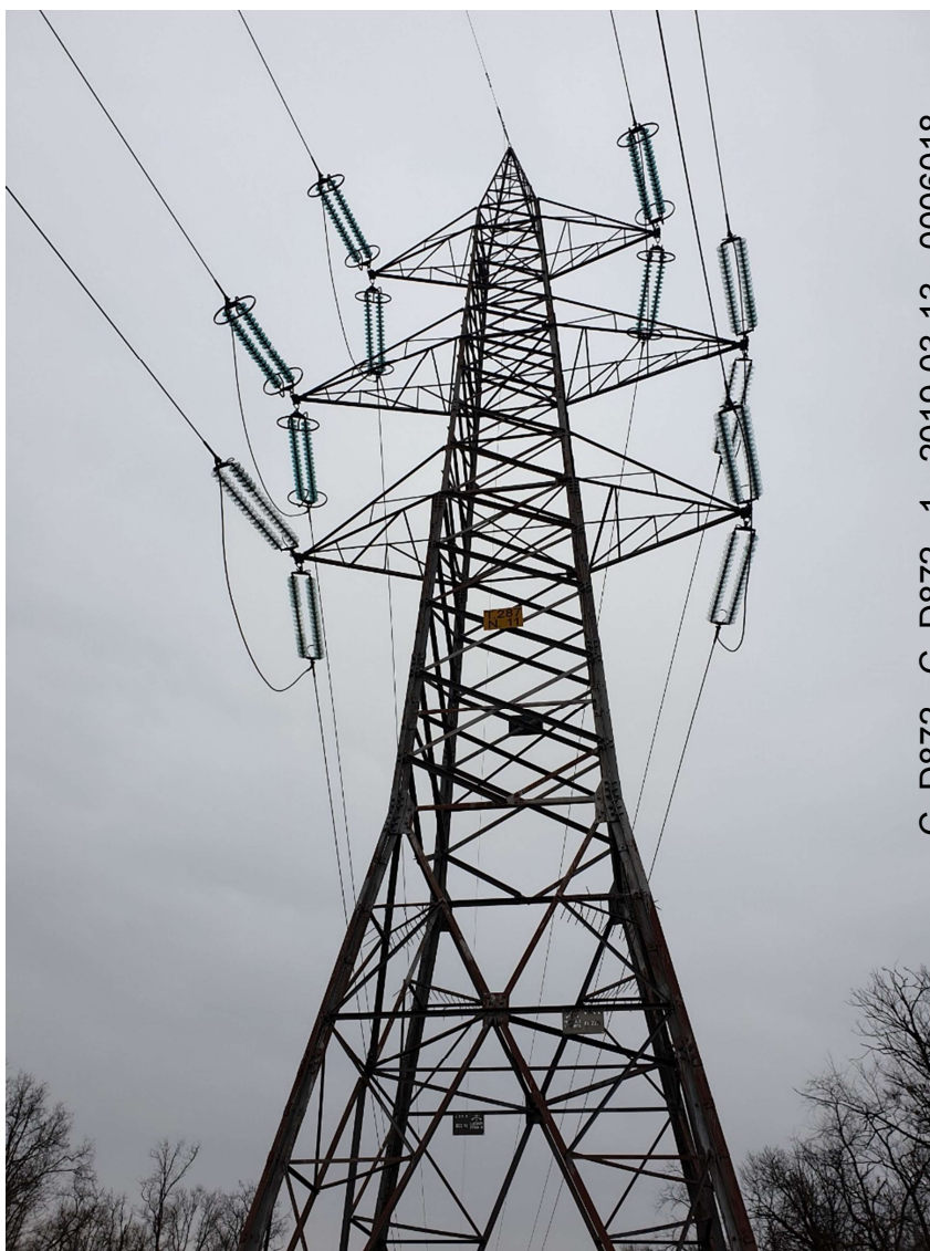
Traliccio linea T.287 – 220 kV
